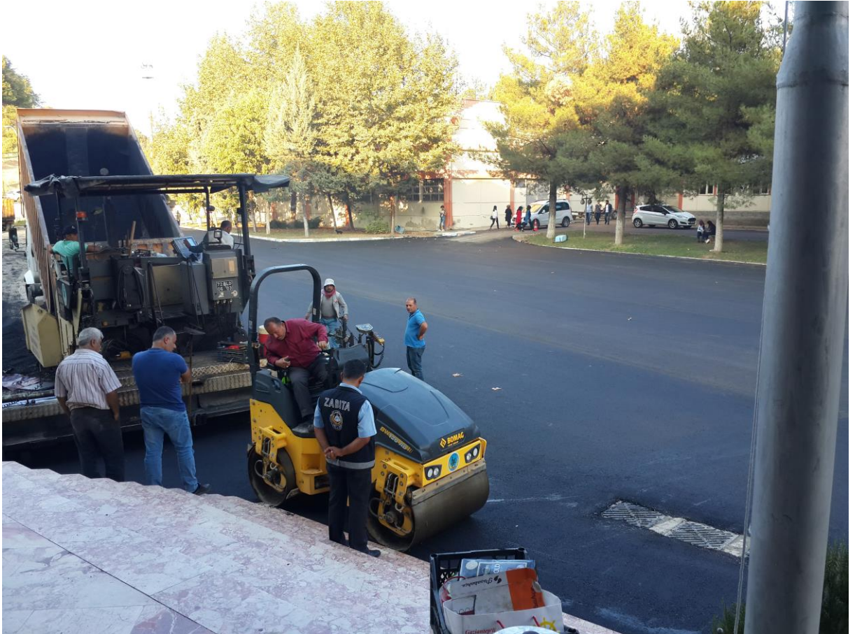
Merkez Kampüs Altyapı İşleri
