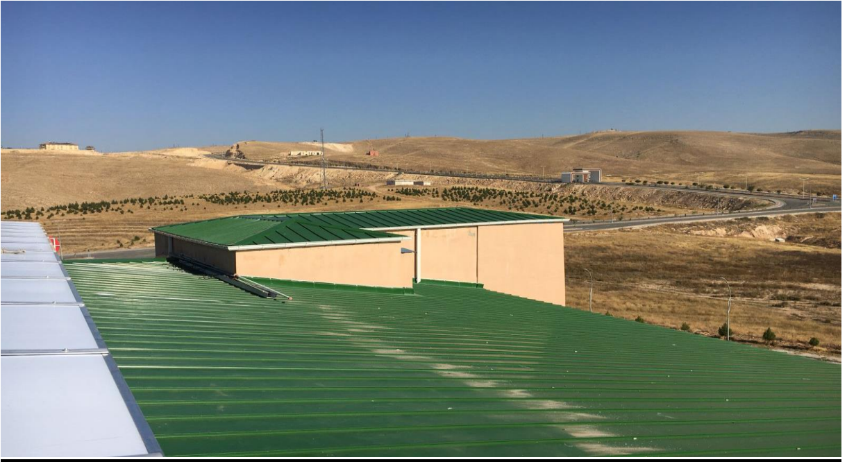
Rektörlük Binası ve Mühendislik - Mimarlık Fakültesi Binaları Çatı Onarımı
