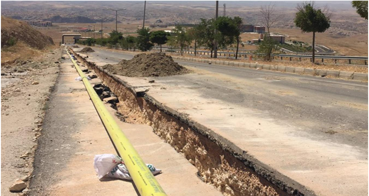
Doğal Gaz Ana Hat Yapım İşi
